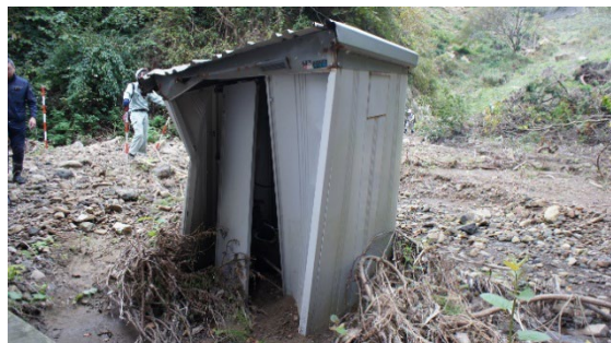
③下流モニタリング井戸の破損
