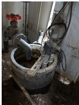
③下流モニタリング井戸の破損
