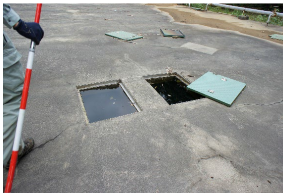
⑤ 浸出水調整槽の埋没内部pHとECの確認
