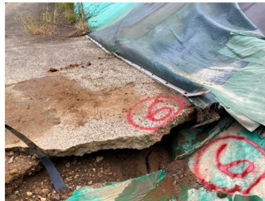
①遮水工の破損、固定工の浮き上がり、フラットバーの破損
