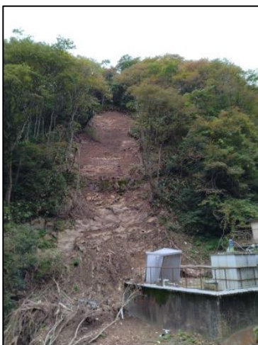
③ 右岸側法面の状況
