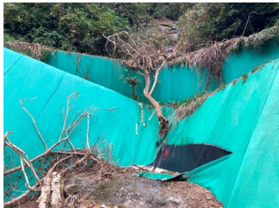
①遮水工の破損、固定工の浮き上がり、フラットバーの破損
