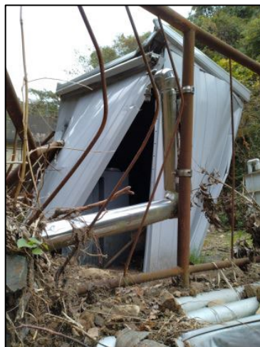
④ 浸出水処理施設関連施設の状況 (本体はほぼ健全)
