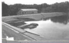
異常降水の継続による埋立地内部貯留水位の上昇
