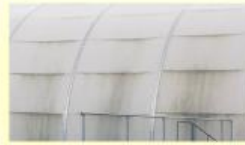
被覆施設の膜面の汚れ
